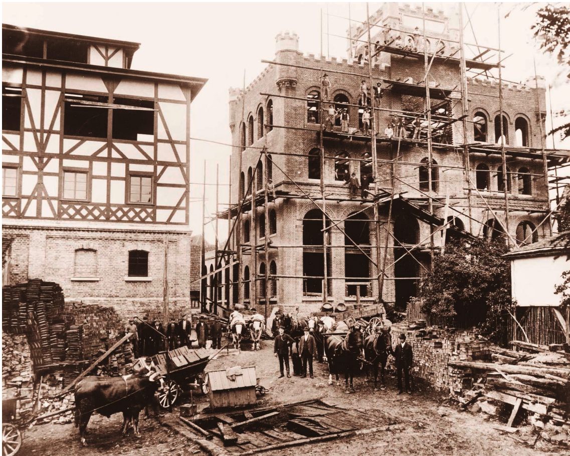
Das neue Sudhaus im Bau, 1903. Links daneben das bereits fertiggestellte Kellergebäude, Original im Stadtarchiv Schwäbisch Hall, Fotosammlung
